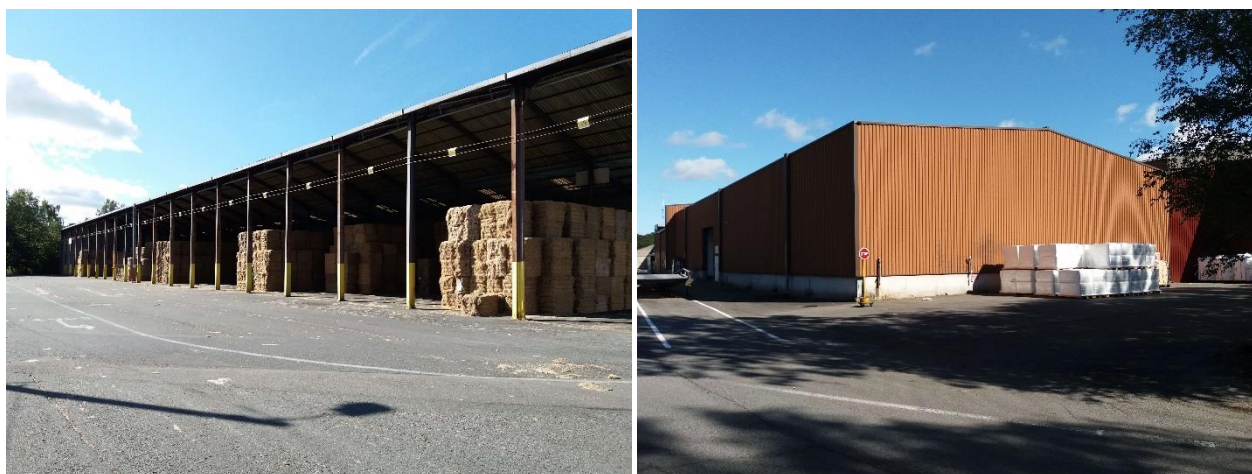
Figure 28 : Illustration de l'ensemble bâtiminaire actuel qui sera remplacé par la Chaufferie biomasse (rappel)
