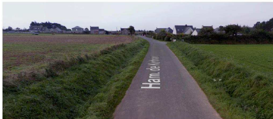
Figure 156 : Fossés situés de part et d'autres de la chaussée au niveau des talus 06 et 07
