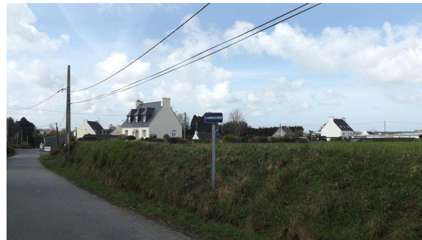
Figure 133 : Entrée du hameau Lannuchen
