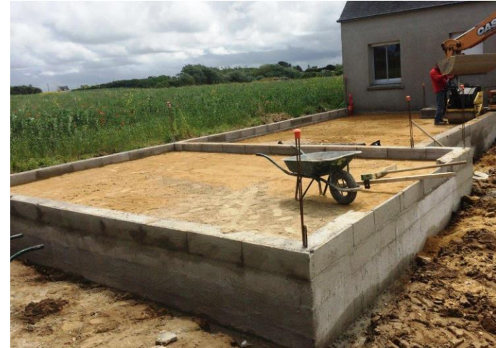
Sablage sous dallage
