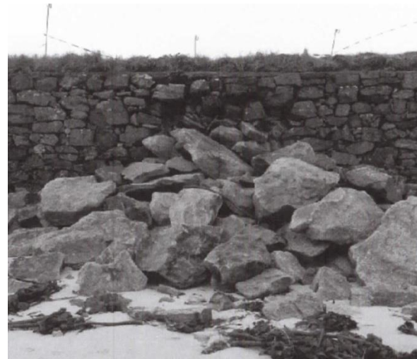
Fourniture de blocs d'enrochement pour consolidation de la digue du curnic à Guissény
