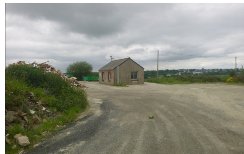
Photographie 6 : Vue vers la partie Nord-Est de l'établissement
