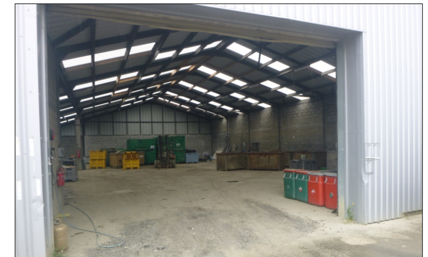
Photographie 11 : Vue sur le hangar existant en partie Nord de l'établissement
