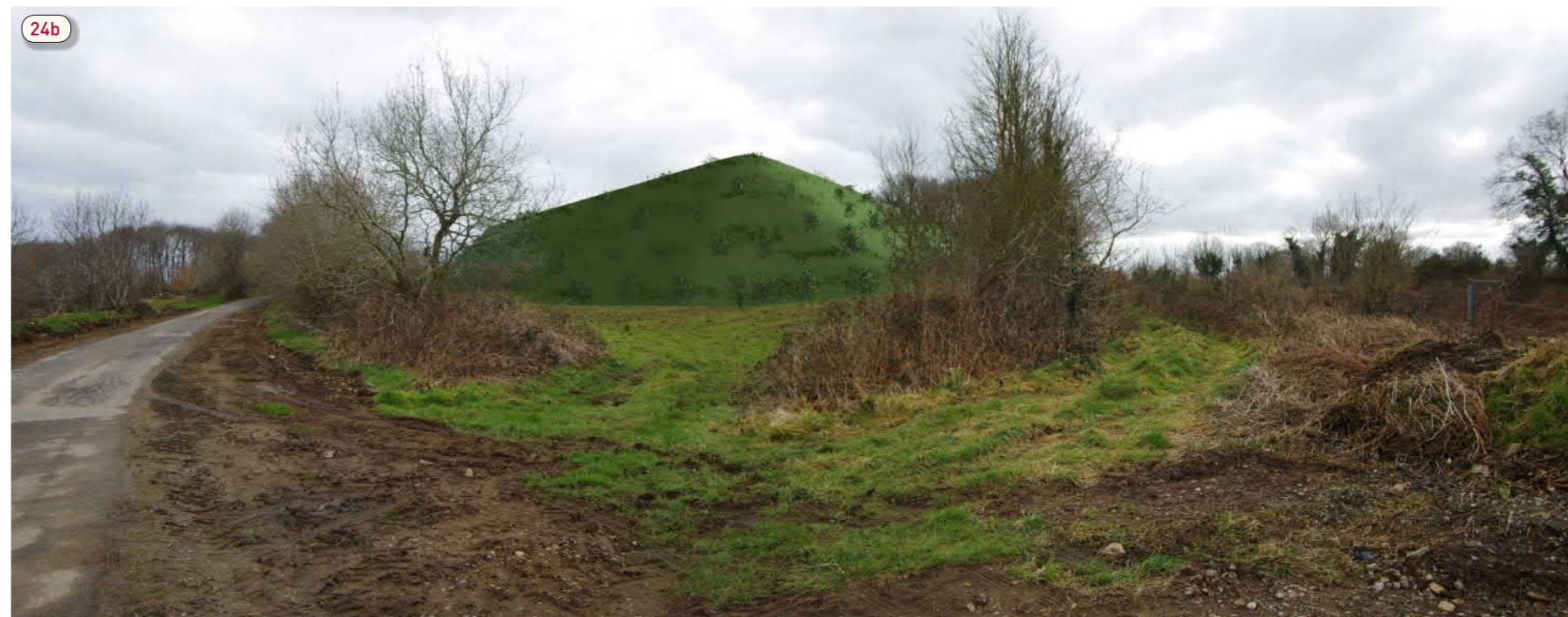
À la traversée de la voie ferrée par l'ouest, le remblai ouest s'imposera au premier plan, encadré par le maillage bocager
