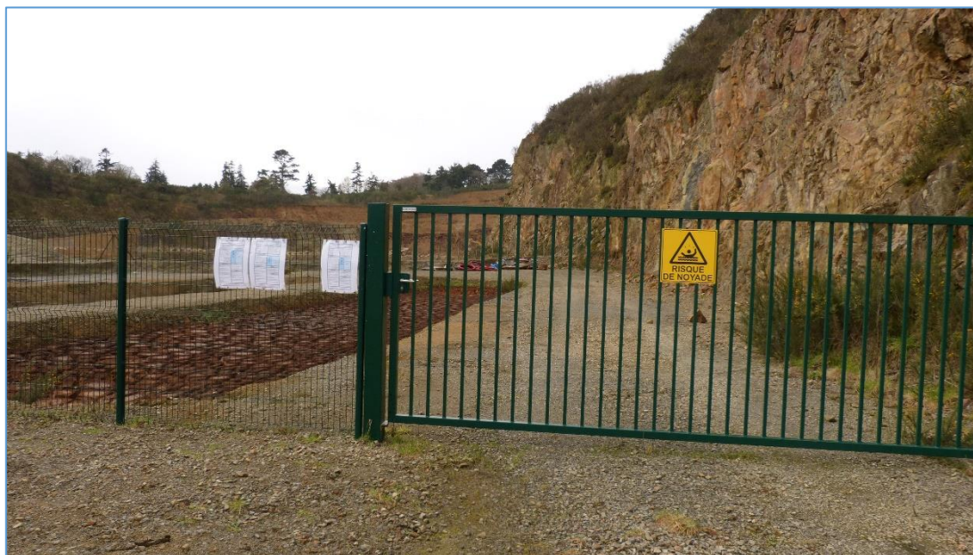
Fig. 34 : Vue sur la signalisation aux abords des bassins de séchage des boues
