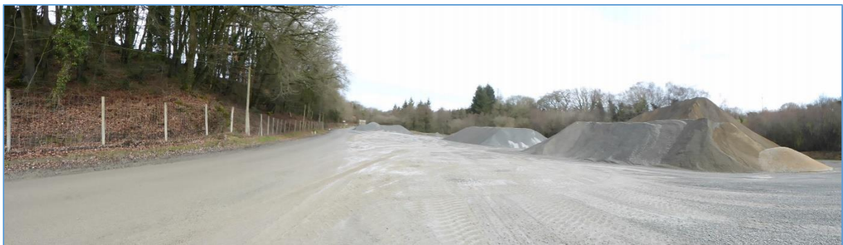
Fig. 39 : Vue n°2 : Plate-forme de stockage des matériaux à l'entrée de la carrière
