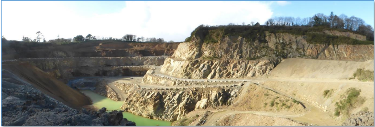
Fig. 44 : Vue n°7 : Zone d'extraction depuis la partie remblayée
