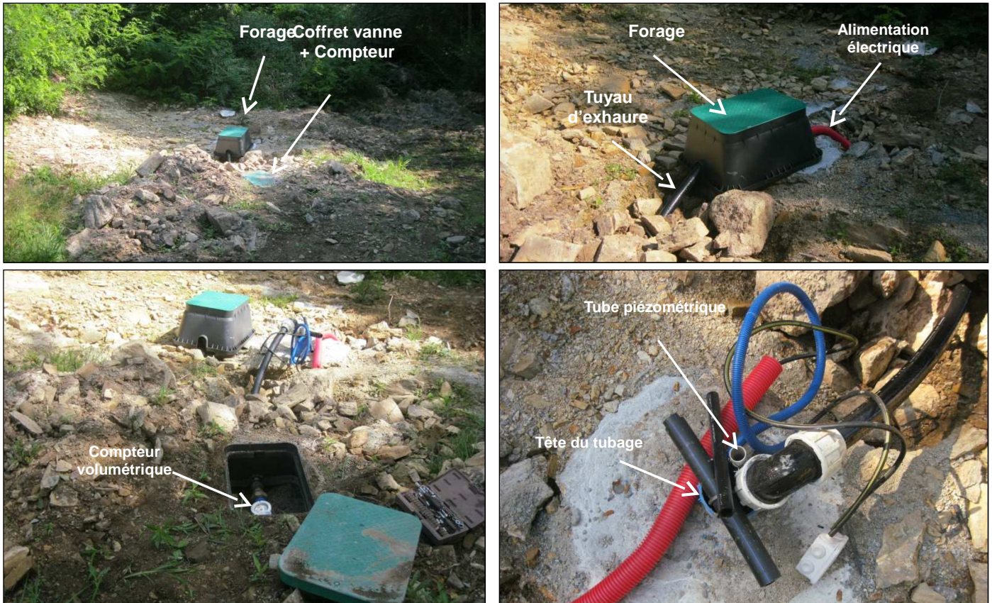
Figures 10 – Vues de la tête de forage et de la fosse technique du compteur volumétrique après la réalisation des travaux et avant la mise en place de la margelle de protection (Photographies : GéoSen – 24-juil-18)
