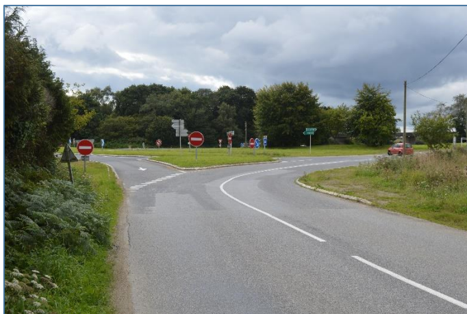
Fig. 14 : 3 - Vue sur la VC n°3 avant raccordement à la RN 165
