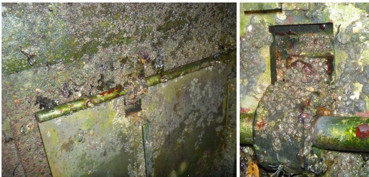
Figure 6 : détails des cavaliers permettant la rotation du clapet
