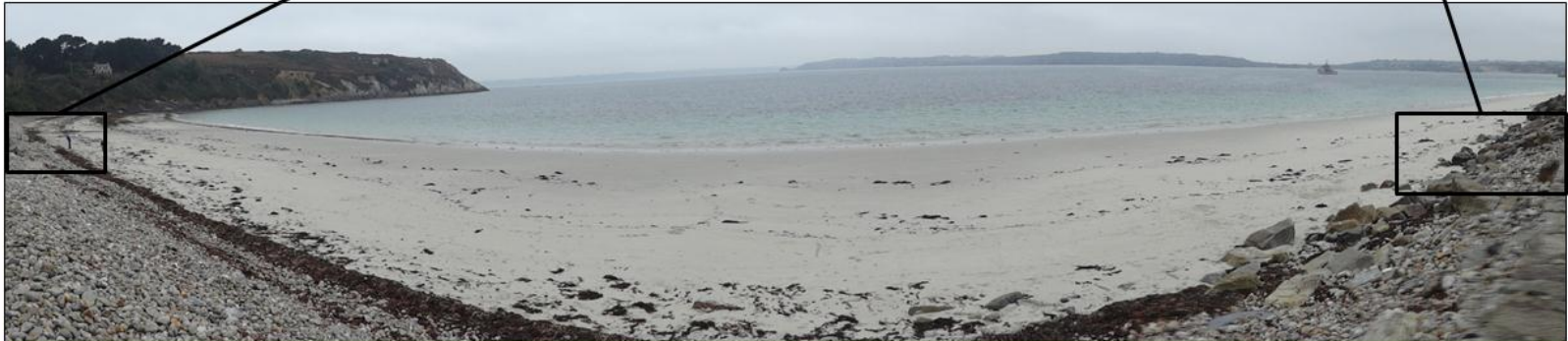
Plage de sable sur l'estran et galets situés en haut de plage contre le perré de protection. Ces galets limitent l'érosion de la plage et l'attaque du perré.
