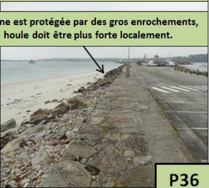
Plage de sable sur l'estran et galets situés en haut de plage contre le perré de protection. Ces galets limitent l'érosion de la plage et l'attaque du perré.
