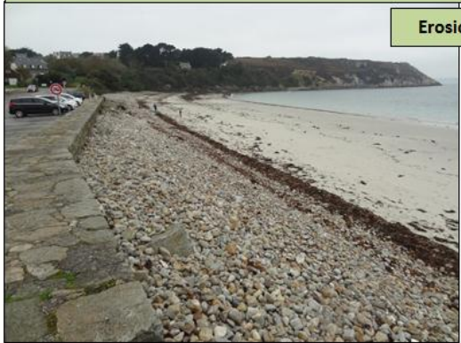
Plage de sable sur l'estran et galets situés en haut de plage contre le perré de protection. Ces galets limitent l'érosion de la plage et l'attaque du perré.
