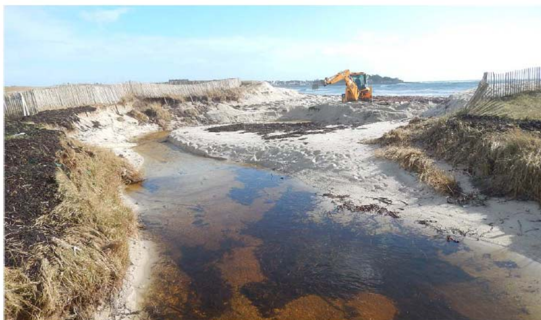
Exemple de brèche au niveau de l'exutoire de la Dour Red – commune de Guilvinec sur le PPR1 (photo Egis 25 février 2014)
