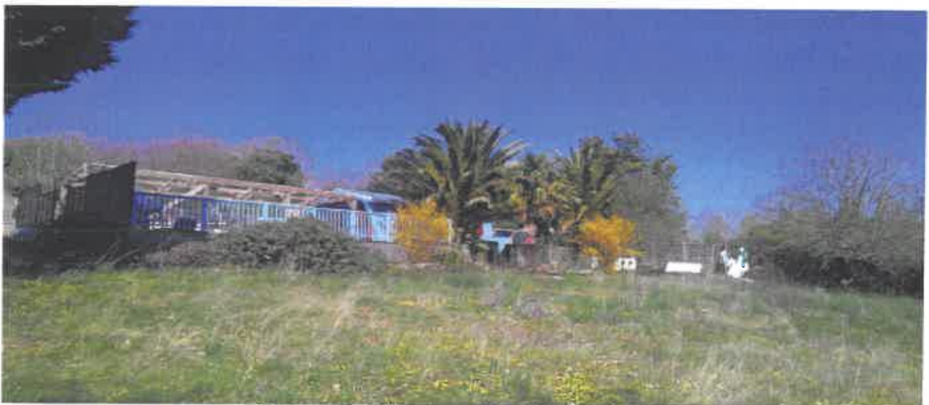
Constructions à démolir pour la renaturation du site
