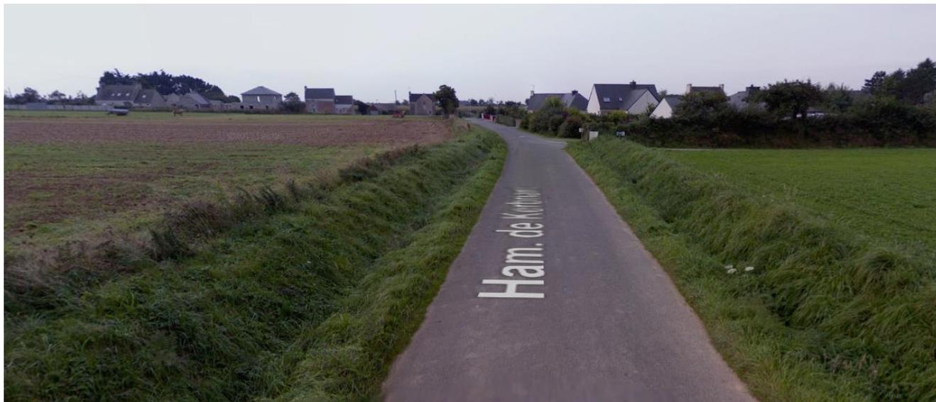
Figure 8 : Fossés situés de part et d'autres de la chaussée au niveau des talus (Talus T06-07)
