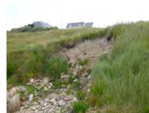
micro-falaise d'érosion marine dans les colluvions sous la parcelle 107
