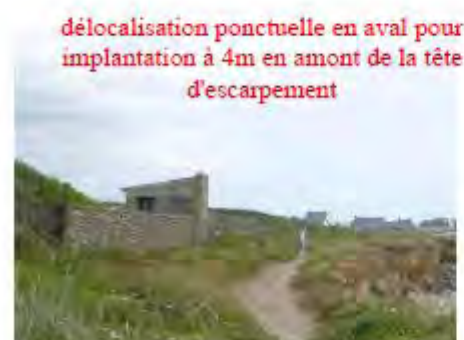
Sentier au droit de la parcelle 143 longé par un mur à une distance minimum de 4.2m de l'escarpement
