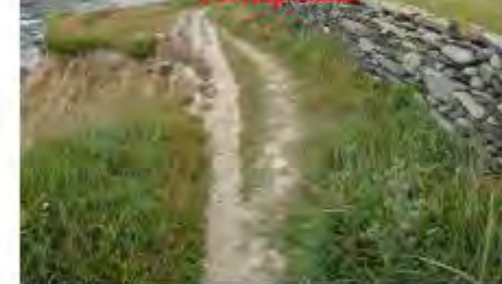
mur situé ponctuellement à 1.8m de l'escarpement au droit de la grotte 2 de la parcelle 665
