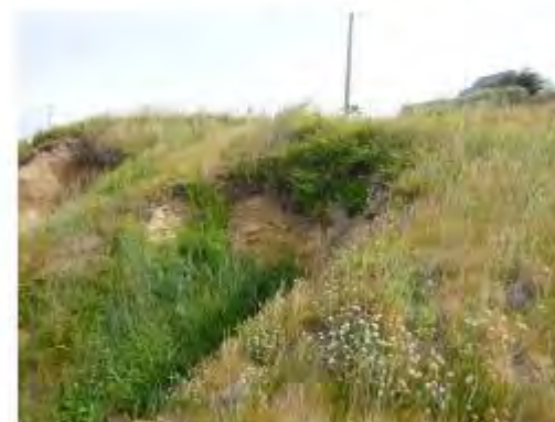
micro-falaise d'érosion marine dans les colluvions sous la parcelle 106
