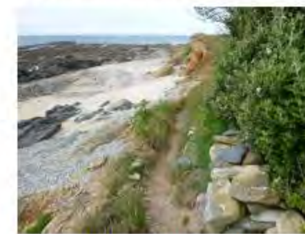
Sentier au droit de la parcelle 760 à délocaliser en tête de versant
