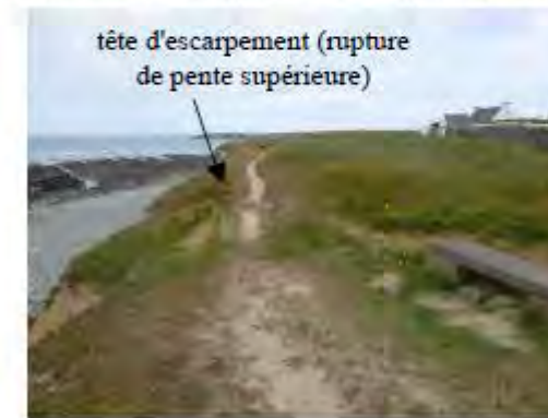
Sentier à délocaliser ponctuellement au droit de la parcelle 500 compte tenu d'une distance minimum de 0.9m entre l'escarpement et le bord de sente
