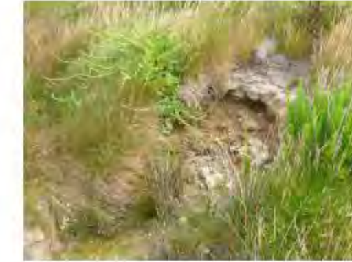
glissement dans des colluvions au droit d'un secteur présentant d'importantes circulations d'eaux au droit de la parcelle 97
