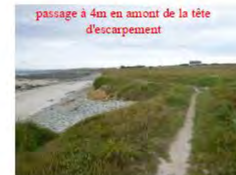
Sentier au droit des parcelles 508 et 509 à délocaliser très ponctuellement
