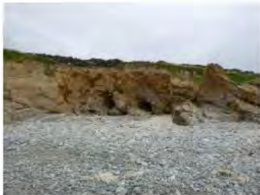
développement de grottes de 1.5m de profondeur sur la moitié basse de l'escarpement côtier par érosion marine au droit de la parcelle 665
