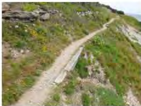
sous-cavage d'une poutre de confortement de la rive de sente par érosion marine de la plage ancienne Monastérienne au droit de la parcelle 88
