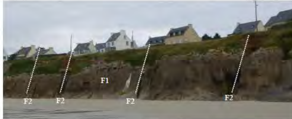
fracturation du massif rocheux sous les parcelles 107 à 104
