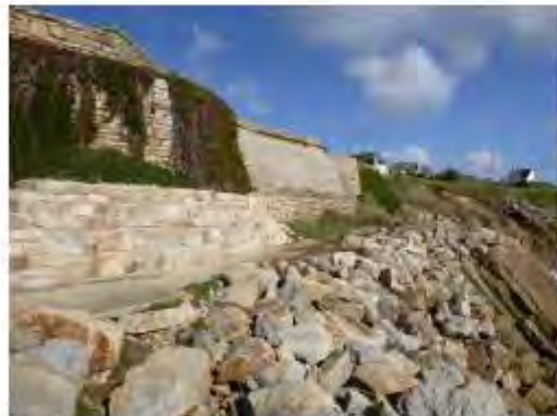
Versant protégé par perré en enrochements ( V_{ind} 0.1 \text{ à } 0.01\text{m}^3 ) et mur de soutènement au droit de la parcelle 103
