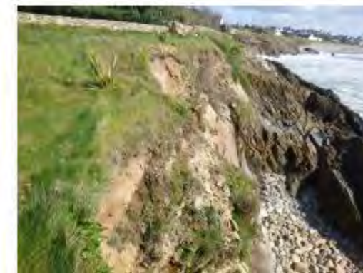
passage du sentier au droit de la parcelle 102
