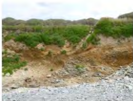
micro-falaise d'érosion marine dans l'escarpement côtier au droit de la parcelle 495
