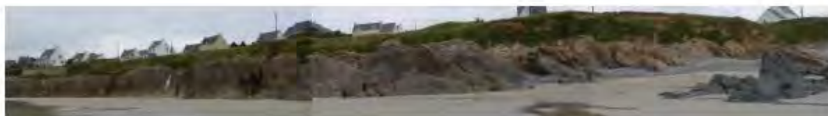
succession de glissements localisés dans un manteau de matériaux meubles et encoches d'érosion marines au droit des fractures subméridiennes au niveau des parcelles 104 à 107
