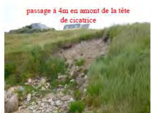
Sentier au droit de la parcelle 107 à délocaliser ponctuellement de ~3m en amont compte tenu d'une distance actuelle de 0.8m entre l'escarpement et le bord de sente
