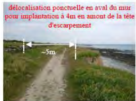
contexte géomorphologique au Sud de la parcelle 665 mur à 5m
