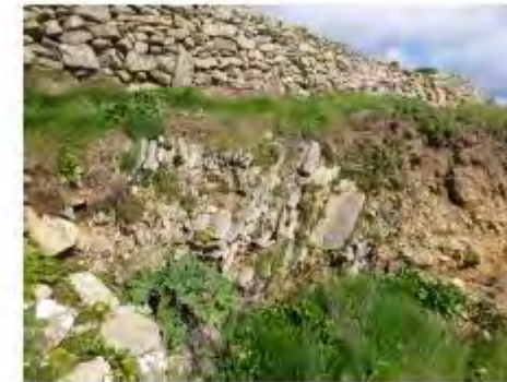
Affleurement d'altérite gneissique au droit de la parcelle 95
