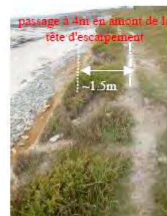
Sentier au droit des parcelles 511 et 510 à délocaliser sur ~40m
