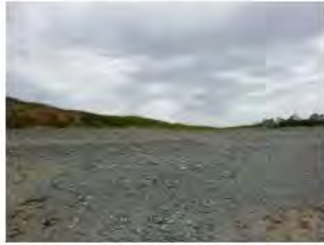
cordon de galets au droit des parcelles 500 et 499
