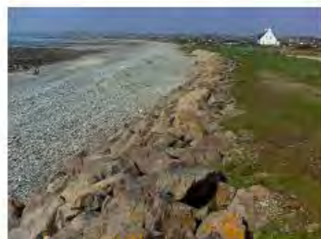
Photo 1 : Enrochement, secteur E
