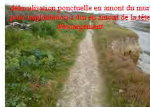
Sentier au droit de la parcelle 142 longé par un mur à une distance minimum de 3.5m de l'escarpement
