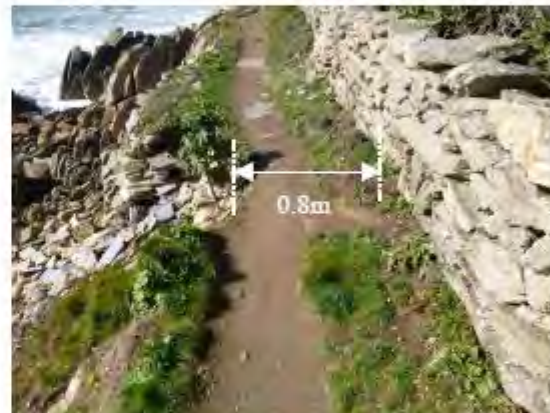
passage de sente recommandé en amont de muret au droit de la parcelle 85
