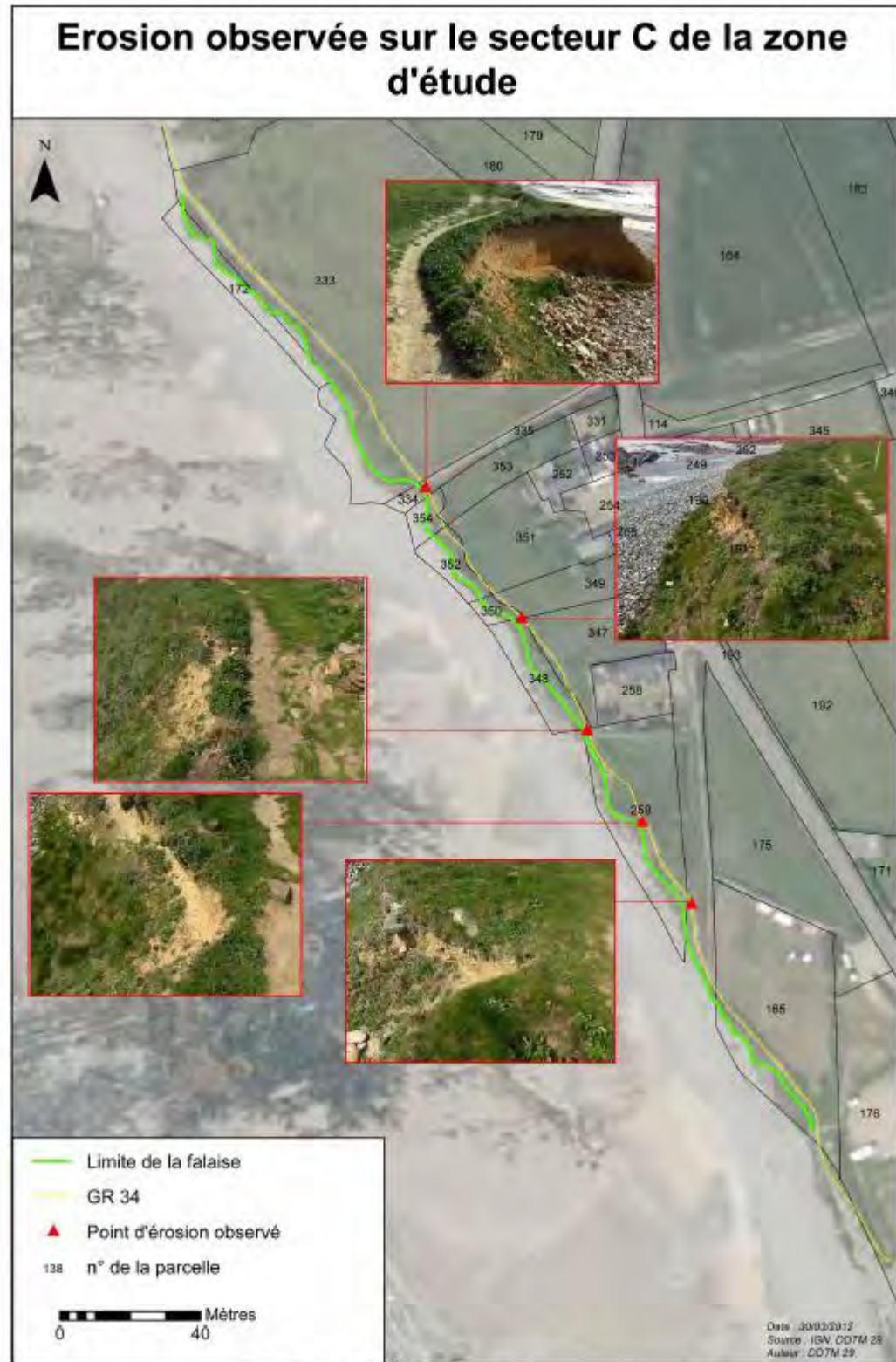
Figure 4 : Points d'érosion observés sur le secteur C
