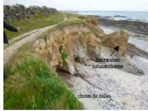
rupture du massif rocheux le long de la fracturation subméridienne et chute de dalles rocheuses au droit de la parcelle 665
