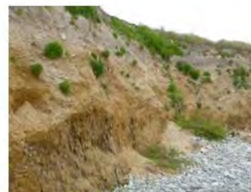
glissement des limons argilo-sableux présent en tête de profil et micro-falaise d'érosion marine dans les schistes altérés sous la parcelle 503
