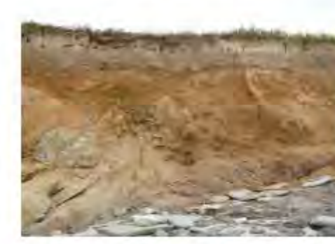
Affleurement d'altérites schisteuses très décomposées surmontées d'un niveau de galets puis de limon argilo-sableux au droit de la parcelle 512
