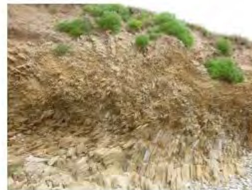
chute de plaquettes rocheuses au droit de la parcelle 694
