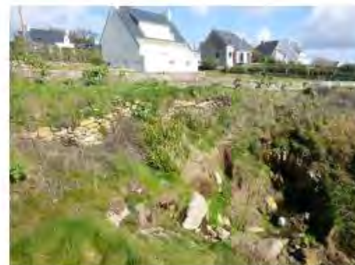
Versant partiellement conforté par un muret de soutènement de l'assise du sentier au droit de la parcelle 98
