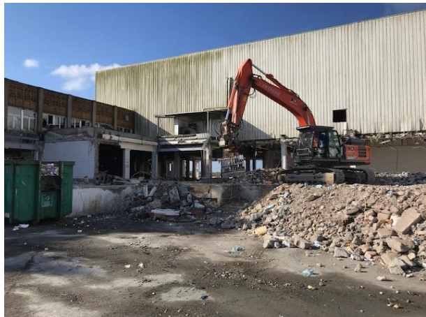
Démolition de l'avant du bâtiment 2
