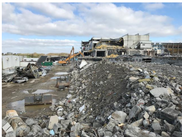
Aperçu de l'avancement de la démolition vers le Bât. 2
