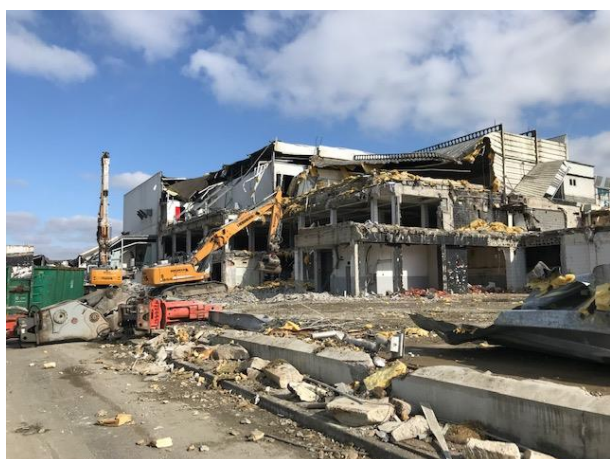
Aperçu des travaux de démolition en cours
