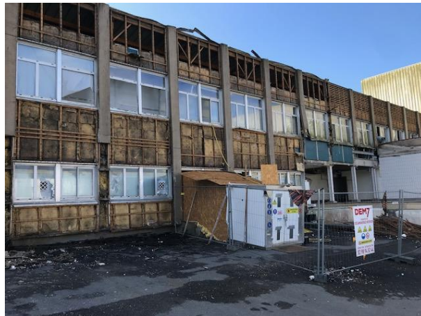
Bâtiment 1 curé en extérieur avant désamiantage
